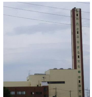
【建築後28年経過した清掃センター】
